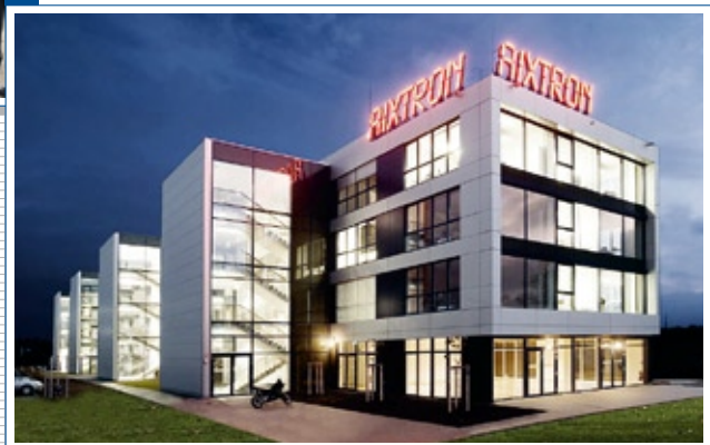
04 BÜROKOMPLEX IM OKTOBER 2010 //
